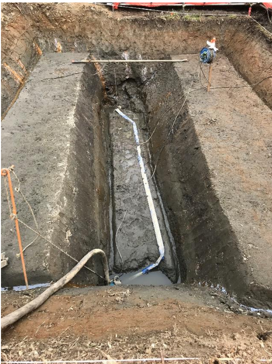
公開された30号トレンチ 湧水をポンプで排水しながら調査
